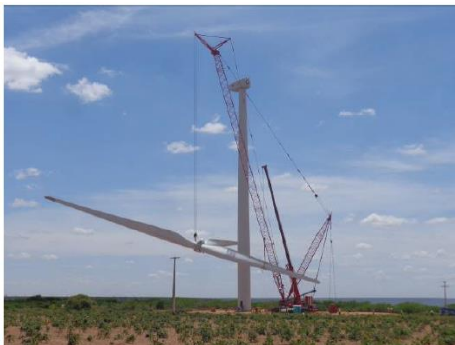
Figura 21 - Montagem das pás
