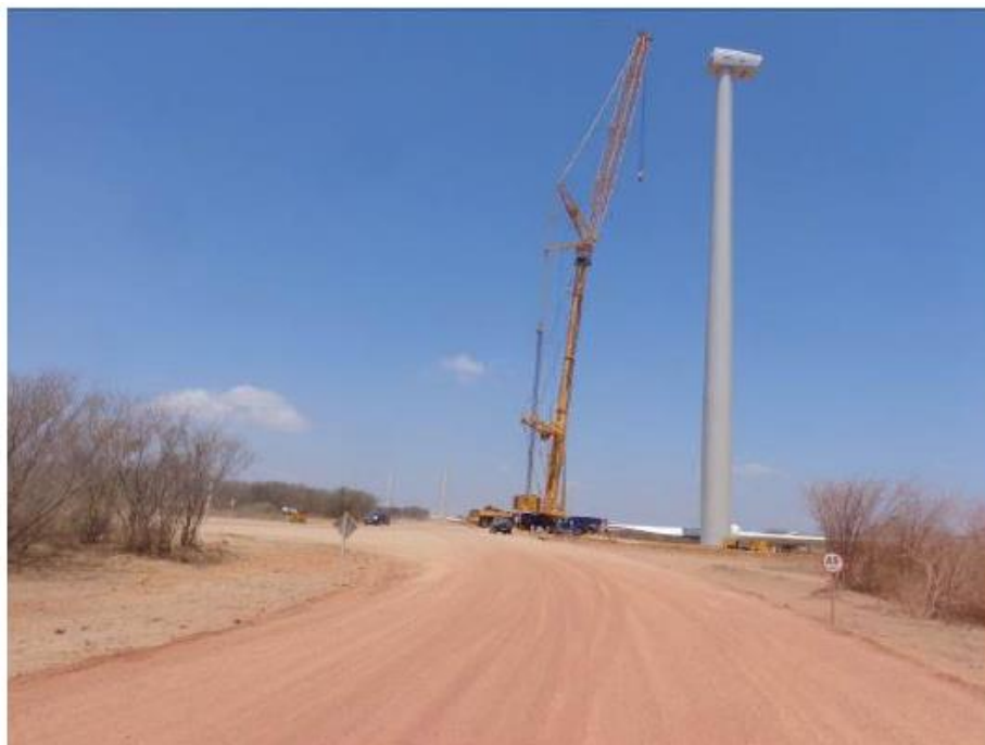
Figura 20 - Montagem da nacele
