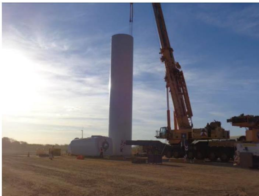
Figura 18 - Montagem do primeiro seguimento da torre
