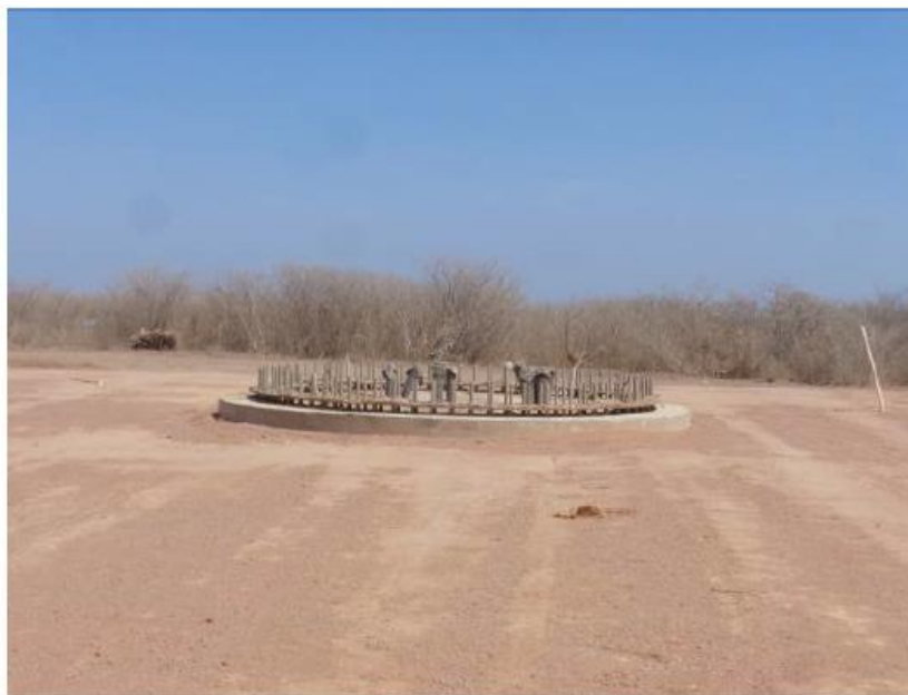
Figura 17 - Base pronta para montagem do aerogerador
