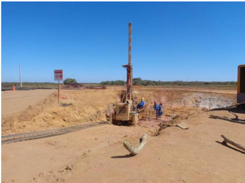
Figura 14 - Execução de estaca raiz na área da base dos aerogeradores
