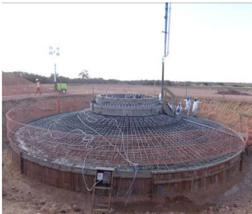
Figura 15 - Base em processo de concretagem
