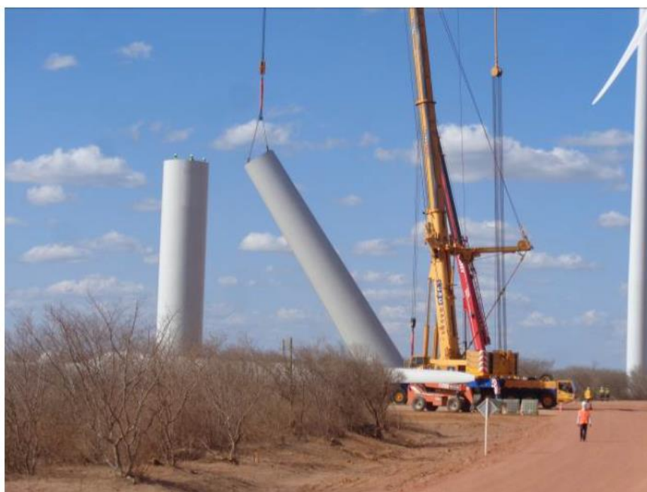
Figura 19 - Montagem do segundo seguimento da torre
