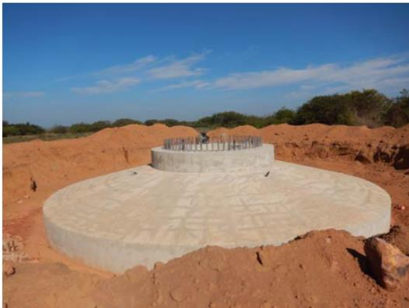
Figura 16 - Base concretada
